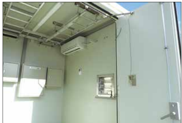
付帯電気工事
