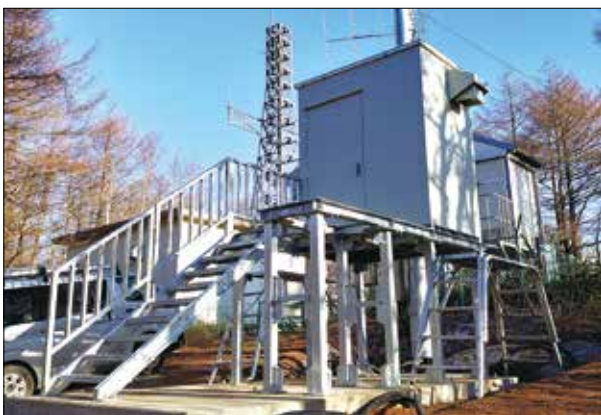
局舎架台製造
